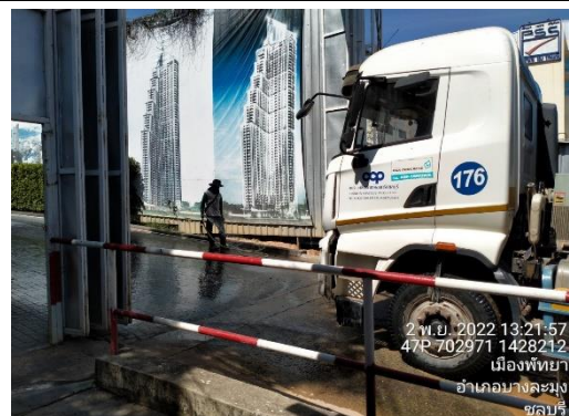
รูปที่ 5 พื้นที่ล้างล้อรถก่อนออกจากพื้นที่โครงการ
